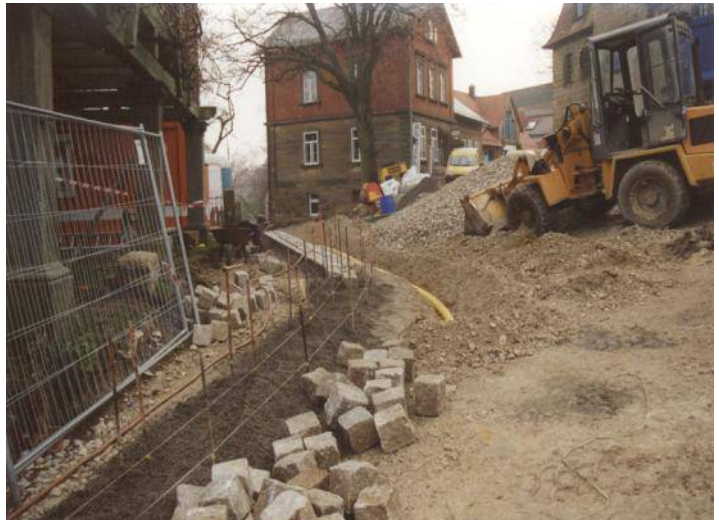
Pflasterarbeiten an der Linde, aufgenommen am 22.11.02
